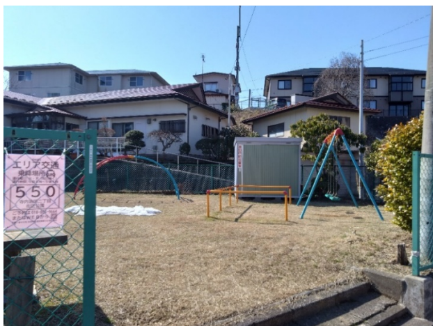
【寺内油田二丁目街区公園と東油田防災倉庫】
